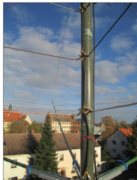
Bild A8: Speiseleitung zwischen den Strahlerebenen
