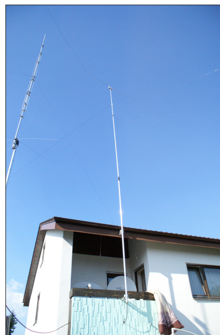
Bild 16: Ansicht des gesamten Einspeismastes mit knapp 16 m Höhe (Dipolkasten) über der Terrasse; der dreiteilige Teleskopmast besteht aus Aluminiumrundrohren.
